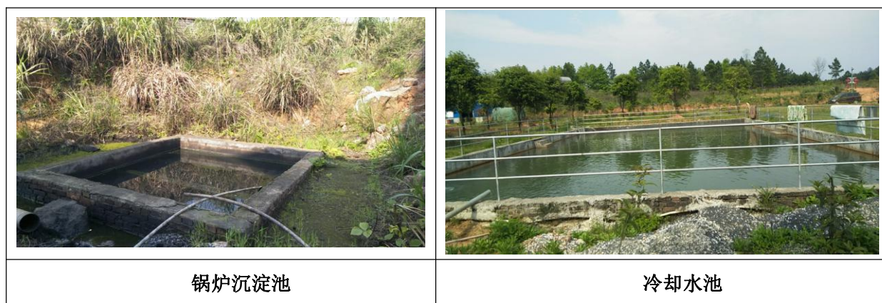
图 4.1-1 项目废水处理设施照片
