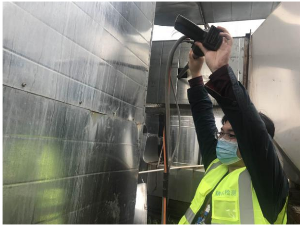
涂胶机排气筒进口
