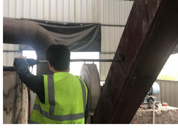
锅炉排气筒出口
