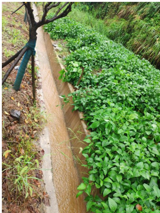
公路沿线排水沟照片
