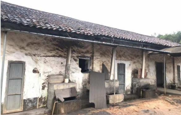
废气处理设施
